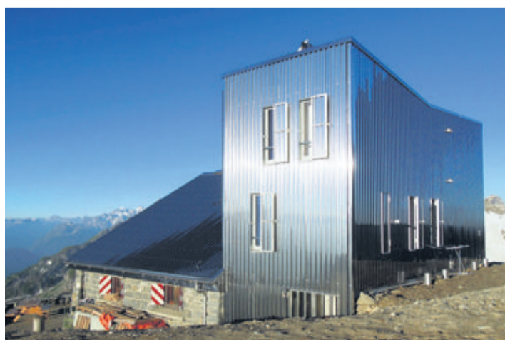
Le toit de la cabane est couvert de panneaux solaires, et celui de l'annexe, en V, permet de récupérer l'eau de pluie. Gilles Simond
